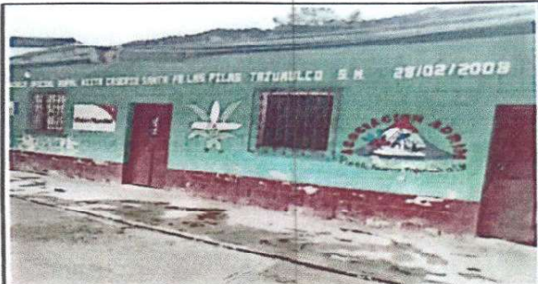
Foto 4: Pintura en muro interior y exterior
