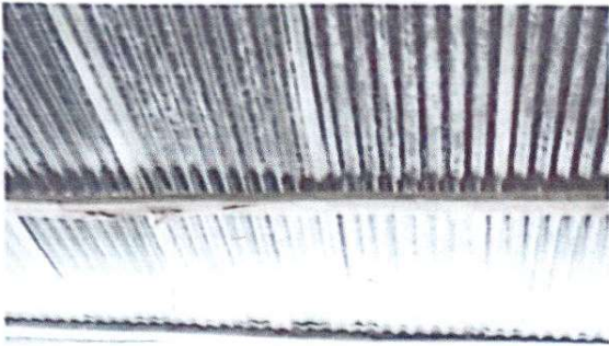
Foto 1: Sustrucción de lamina por lamina troquelada aluzinc calibre 26"
